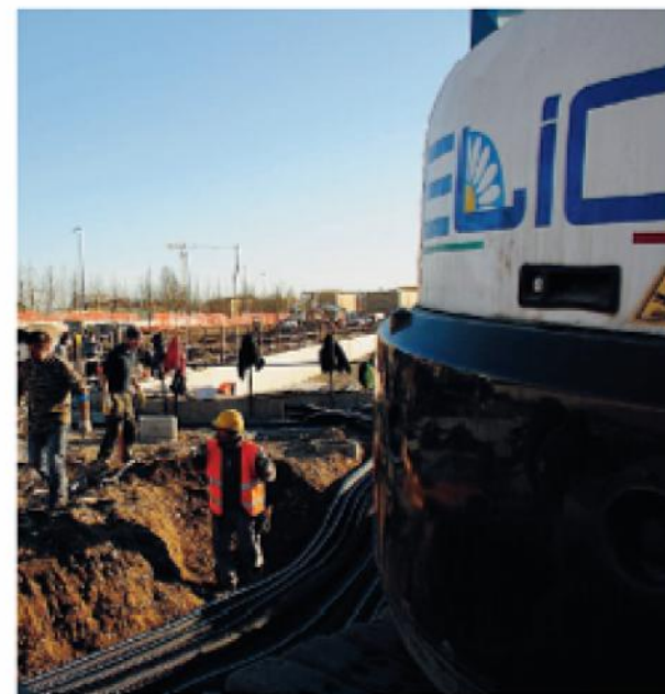
Uomini e mezzi della Elios al lavoro nei cantieri Expo
